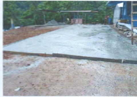
Foto 2: mejoramiento losa de patio
