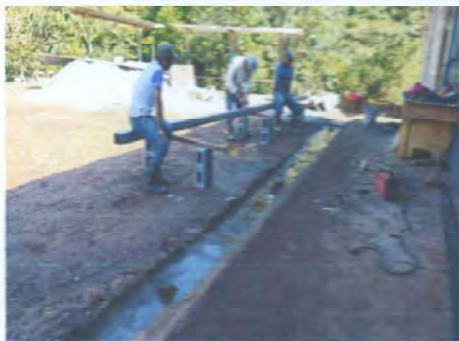
Foto 1: mejoramiento de canales
