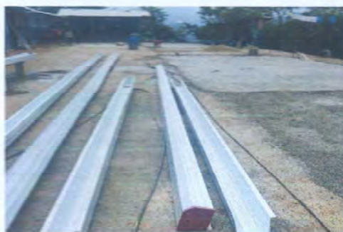
Foto 3: mejoramiento de canales
