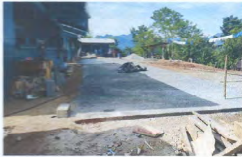
Foto 3: mejoramiento losa de patio
