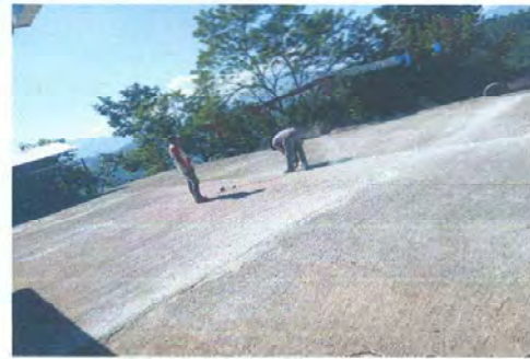
Foto 4: mejoramiento losa de patio
