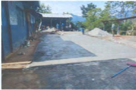
Foto 1: mejoramiento losa de patio
